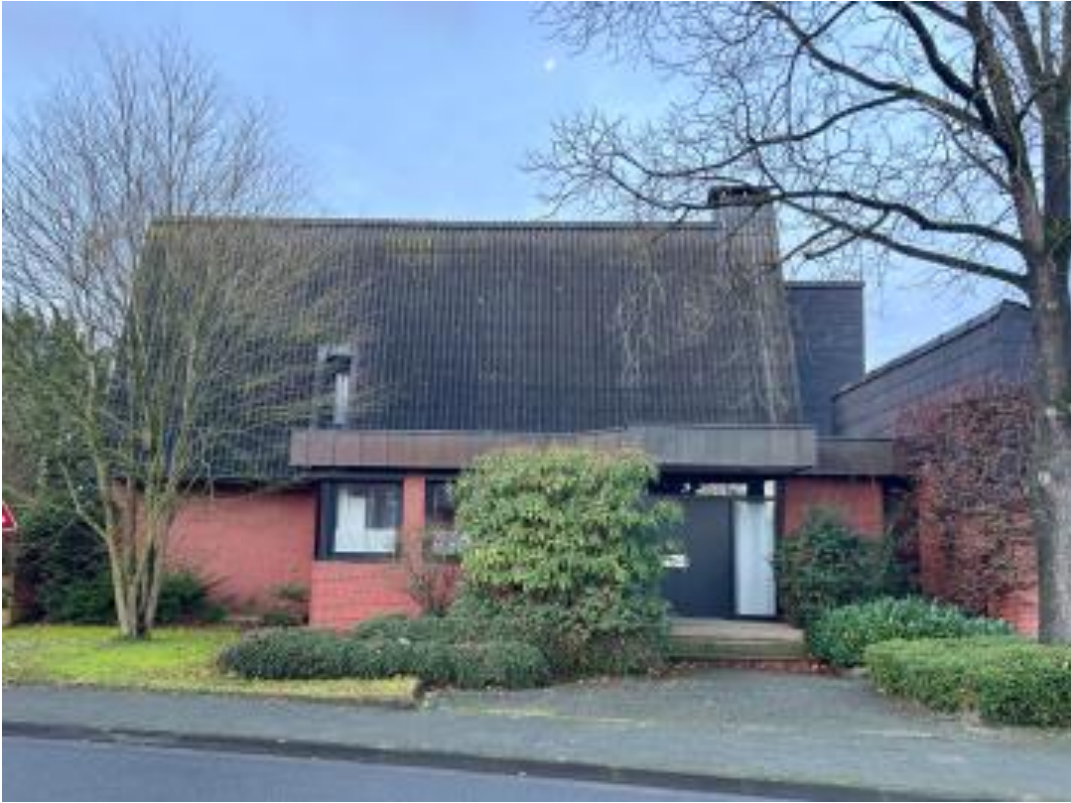
Abbildung 2: Von der Planung betroffenes Gebäude/Vorgartenbereich
